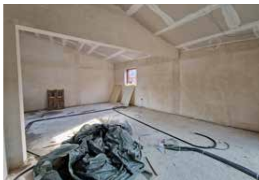
OG PUTZARBEITEN JUGENDRAUM
